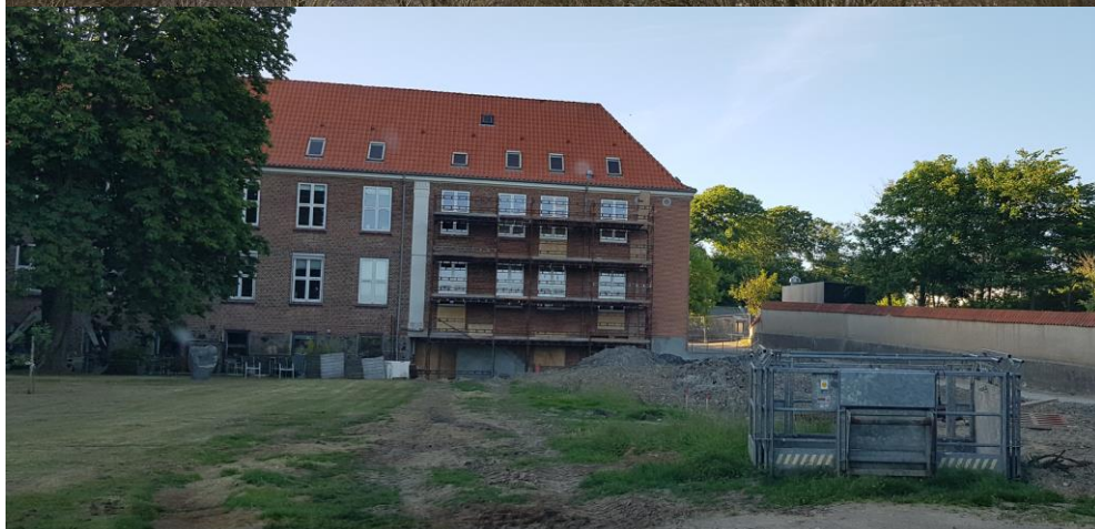
Grunden står klar til opførelse af en ny kommunal bygning. Facaden på den eksisterende bygning renoveres der hvor den var forbundet med den tidligere køkkenfløj
